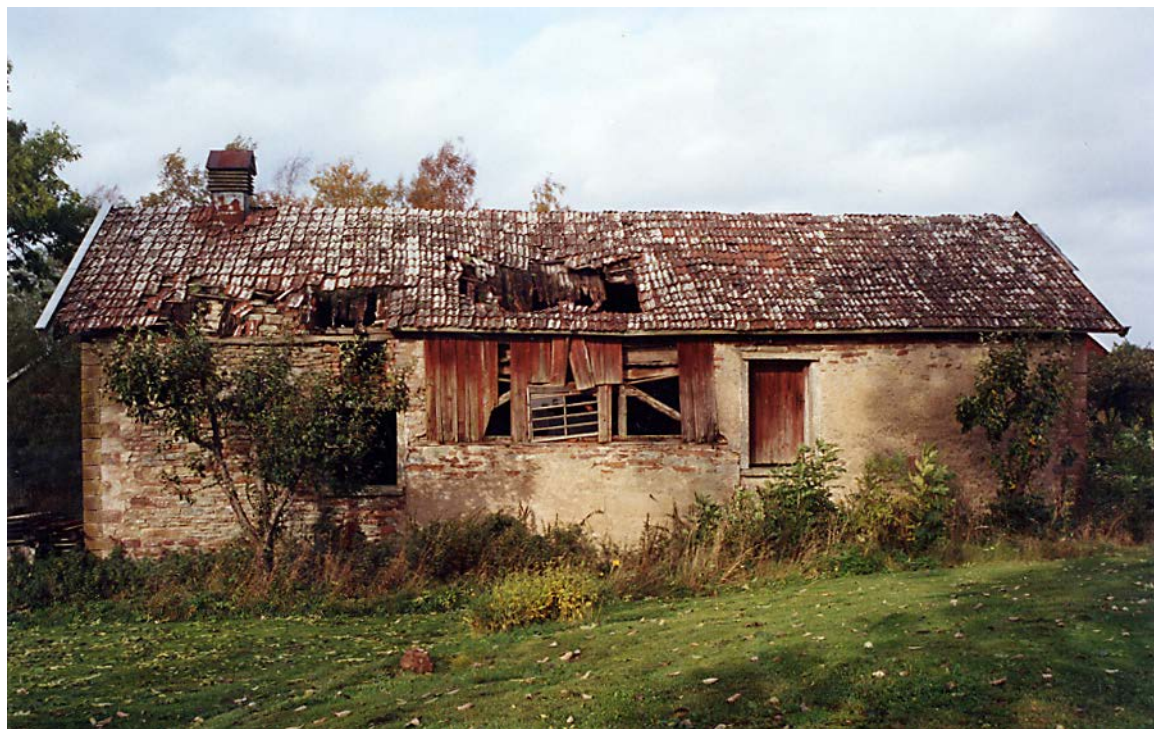
Västerplana mejeri, östra husets fasad mot öster. Allvarliga skador i taket. Okt. 2001.
