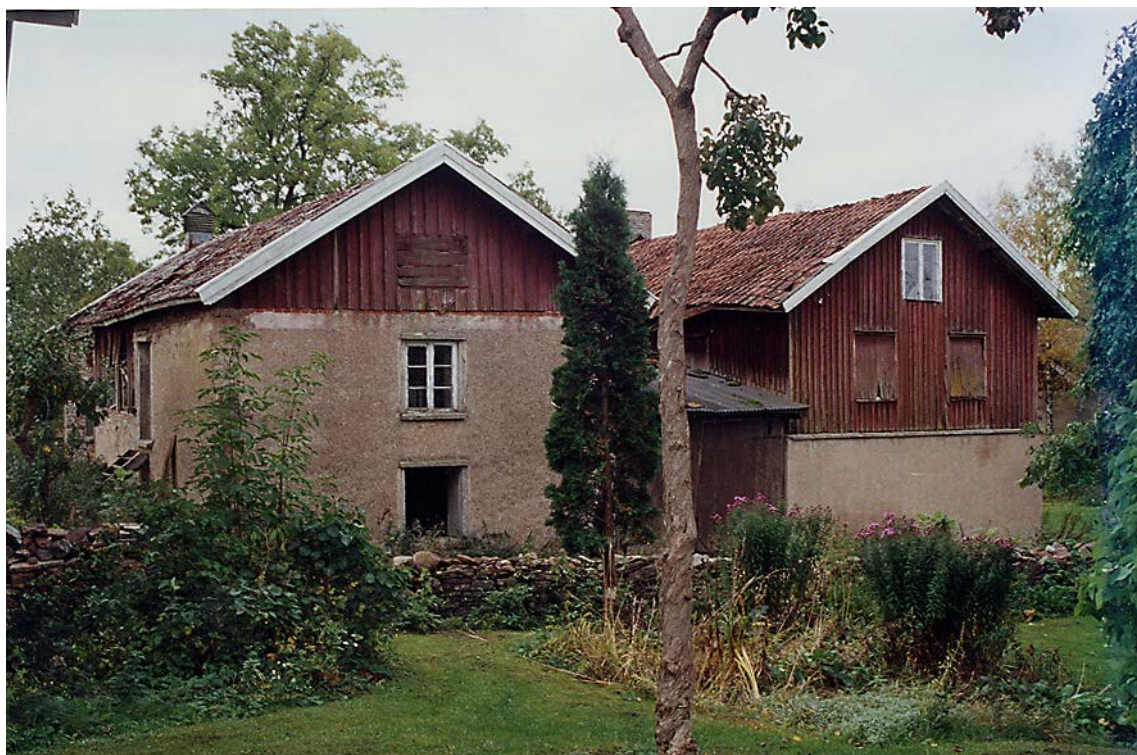
Västerplana mejeri från N, th det gjutna huset med mejeri, magasin och bostad, tv huset med blå kölnan. Foto okt. 2001.
